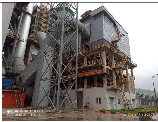
窑尾废气处理设施（布袋除尘器）
