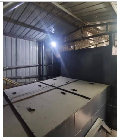
污染土输送收尘系统废气处理设施
