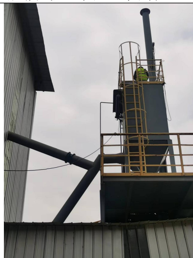
污染土输送收尘系统废气处理设施
