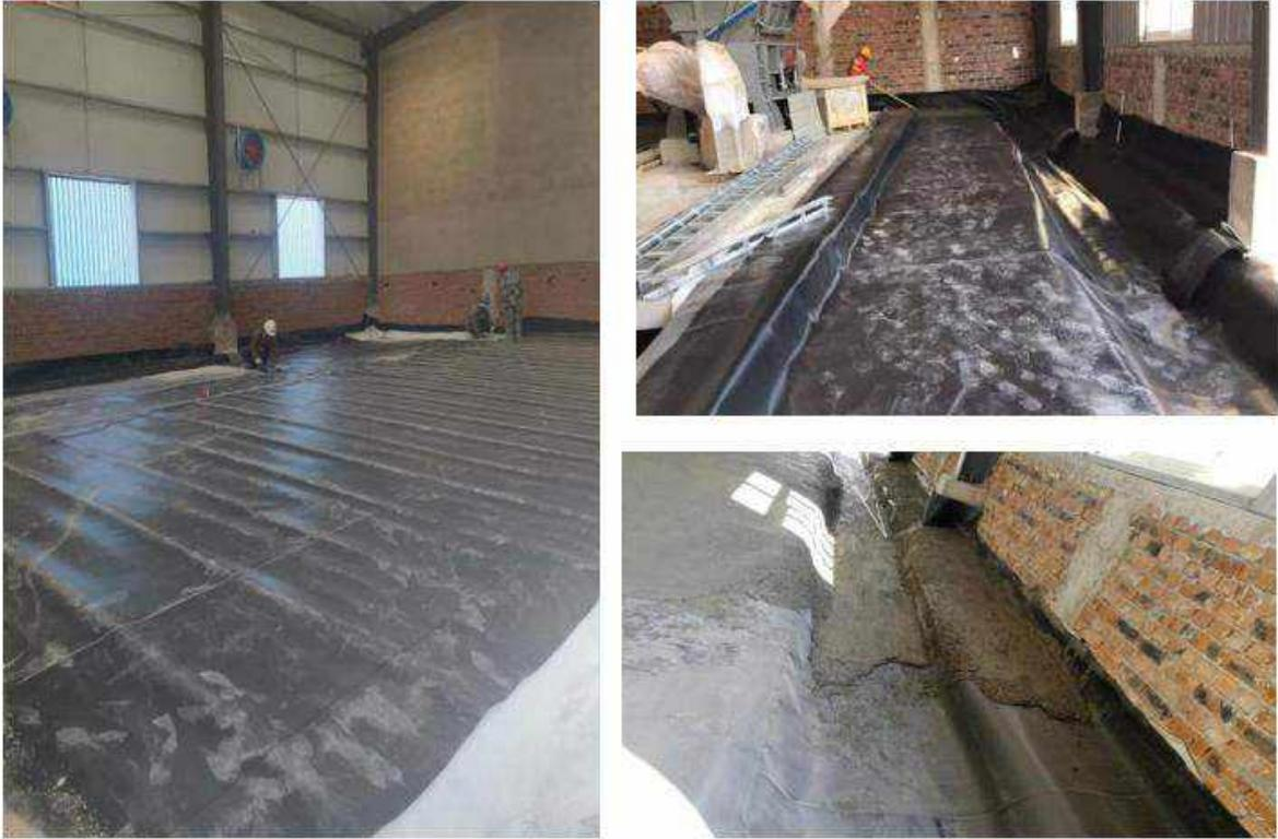
图 4.1-14 防渗施工现场照片
